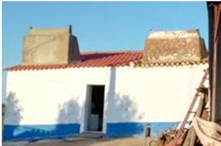
Figura 4.42 – Edifício habitacional do Monte do Outeiro
